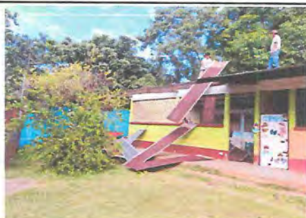
Cambio de lámina por lámina troquelada en proceso
