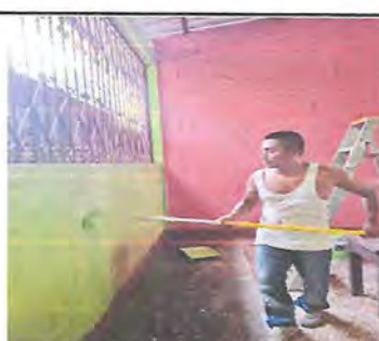
Pintura de paredes en proceso.
