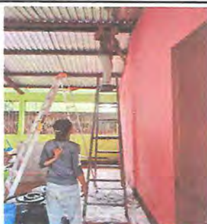
Cambio de sistema eléctrico en proceso
