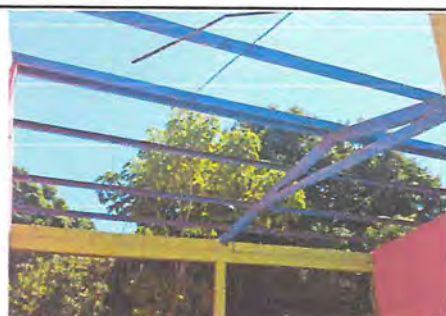
Cambio de estructura metálica en proceso
